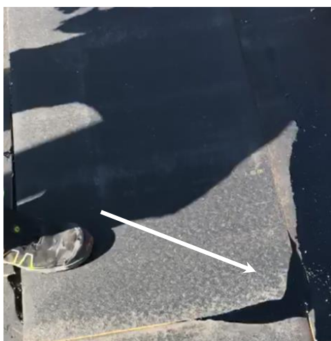
Joonis 15: Isolatsiooniplaadi paigaldamine aluspinnale - Plaadi lõplik paigutamine
