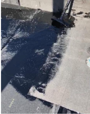
Joonis 18: Hüdrolatsioonikihi kinnitamine isolatsiooniplaatidele (Otsaõmbluse kinnitamine)
