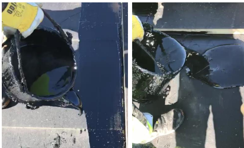
Joonis 13: Isolatsiooniplaadi kinnitamine aluspinnale - Kuumbituumeni valamine
