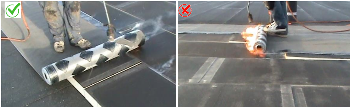
Joonis 11: Eurothane Bi-4 plaatide kinnitamine kuumuse abil (Vasakul: õige kinnitus - osaliselt liimitud aluskiht on kuumusega kinnitatud hüdrolsolatsioonikilele; All: vale kinnitus - isolatsiooniplaadi kuumtöötlemine)
