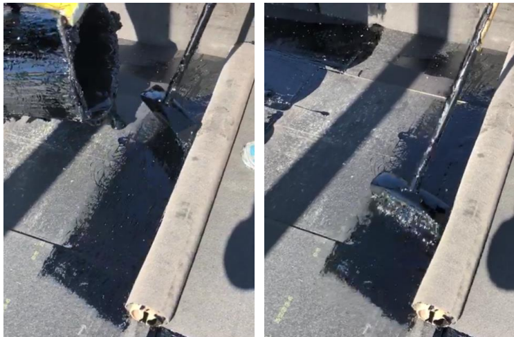
Joonis 16: Hüdroisolatsioonikihi kinnitamine isolatsiooniplaatidele - Kuumbituumeni pealekandmine
