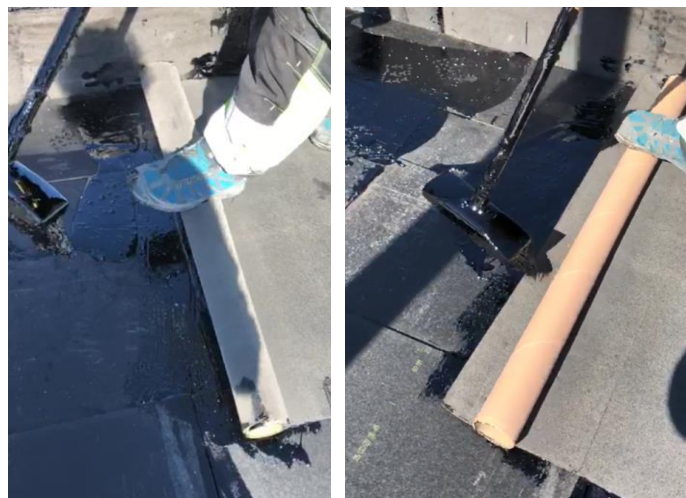
Joonis 17: Hüdroisolatsiooni lahtirullimine jäiga rulliga
