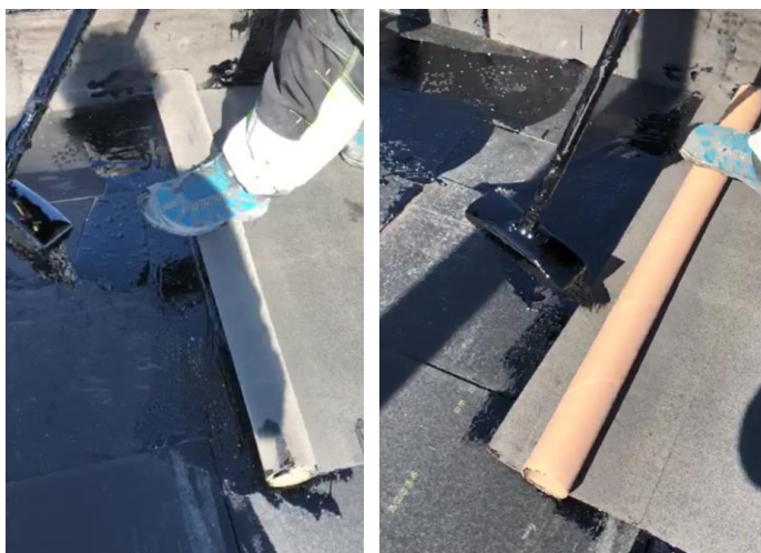
17 17: Hidroizoliacinės membranos išvyniojimas naudojant standų ritinį.
