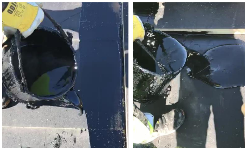
13 13: Izoliacinės plokštės paklojimas ant pagrindo - karšto bitumo užpildymas.
