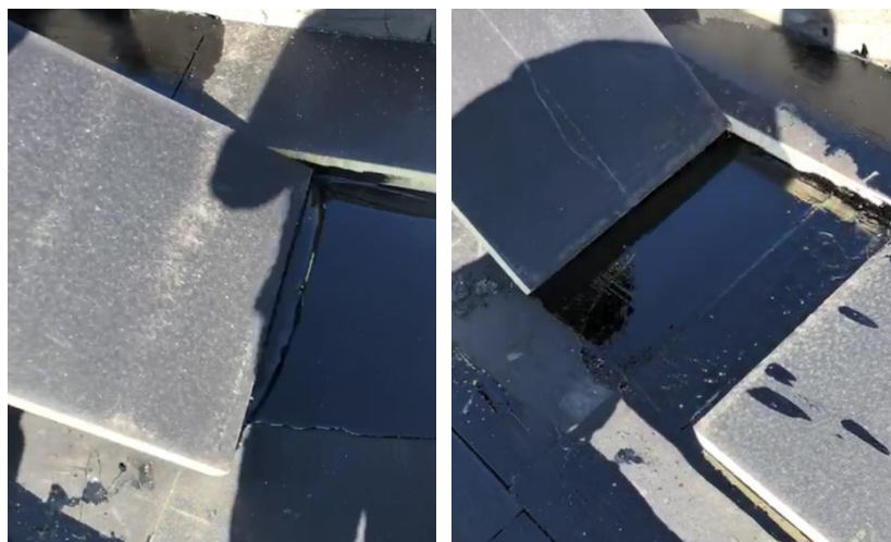
14 14: Izoliacinės plokštės klijavimas ant pagrindo - karšto bitumo paskleidimas izoliacine plokšte.
