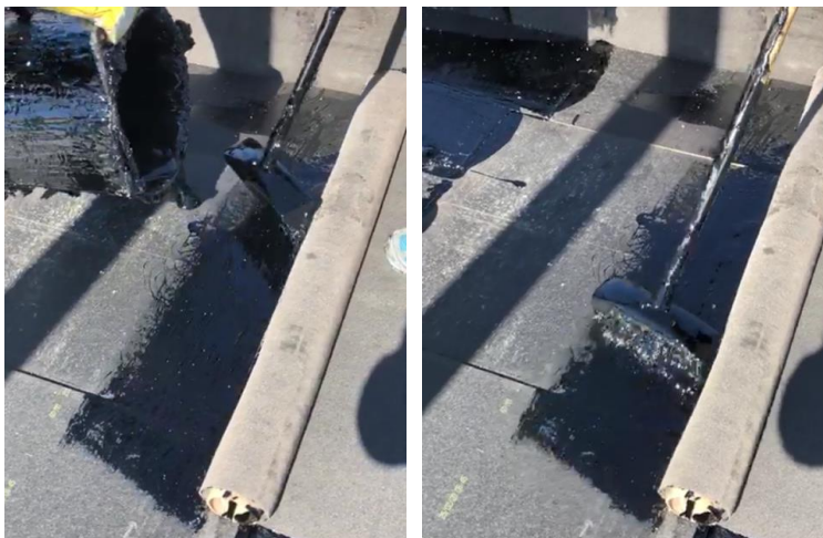
16 16: Hidroizoliacinės membranos tiesimas ant izoliacinių plokščių – karšto bitumo paskleidimas.
