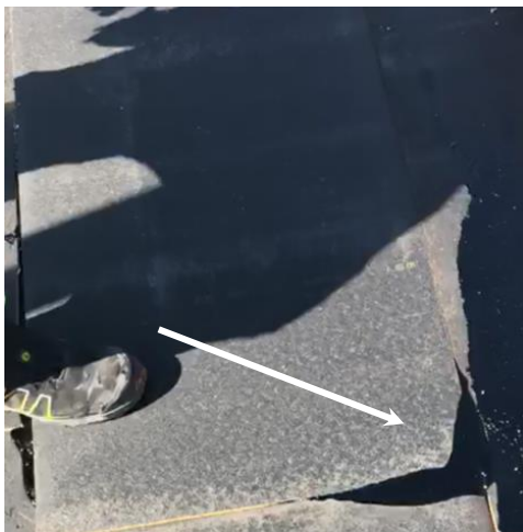
15 15 Izoliacinės plokštės tvirtinimas ant pagrindo - galutinė plokštės padėtis
