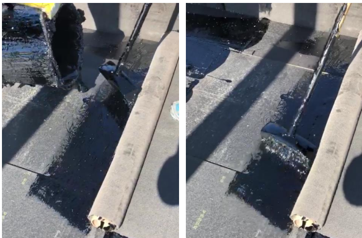
16. attēls: Hidroizolācijas membrānas uzklāšana uz izolācijas plāksnēm – karsta bitumena uzklāšana
