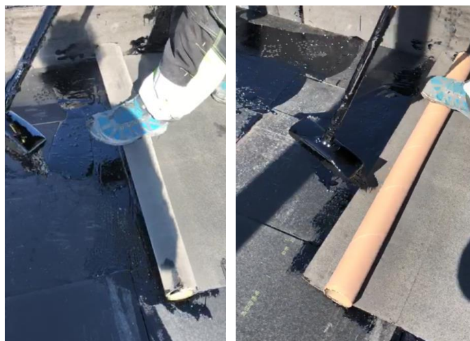
17. attēls: Hidroizolācijas membrānas atritināšana ar stingru rulli
