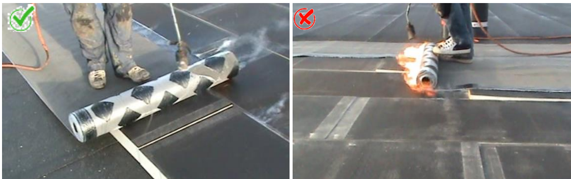
11. attēls: Piekausēšana Eurothane Bi-4 plāksnēm
