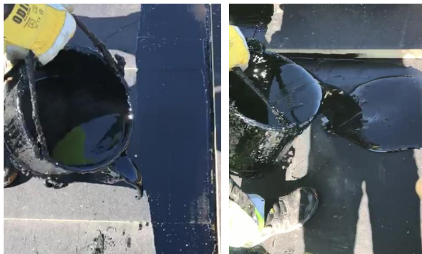
13. attēls: Izolācijas plāksnes uzklāšana pamatnei - karsta bitumena uzliešana
