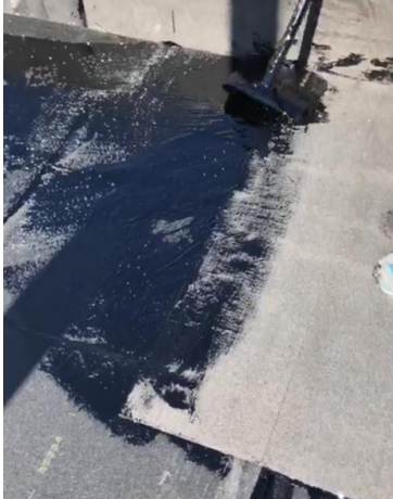
18. attēls: Hidroizolācijas membrānas uzklāšana uz izolācijas plāksnēm (gala šuves fiksācija)
