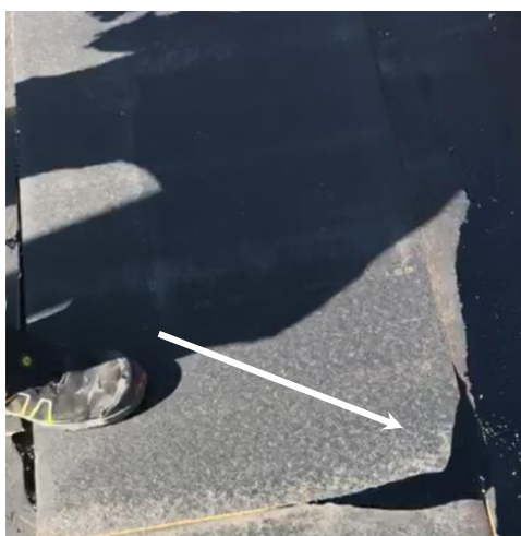
15. attēls: Izolācijas plāksnes uzklāšana uz pamatnes - plākšņu beigu novietošana
